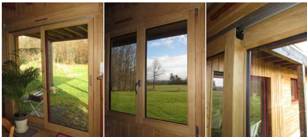
Menuiseries extérieures contemporaines (baies coulissantes, fenêtre 2 vantaux oscillo-battants avec un double vitrage 4 16 4 + gaz neutre argon)
