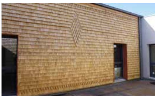
Bardeaux fendus, pose à recouvrement
