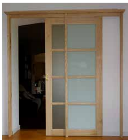
Porte intérieure coulissante avec un verre phonique et opaque, réalisation Atelier du Soleil (24)
