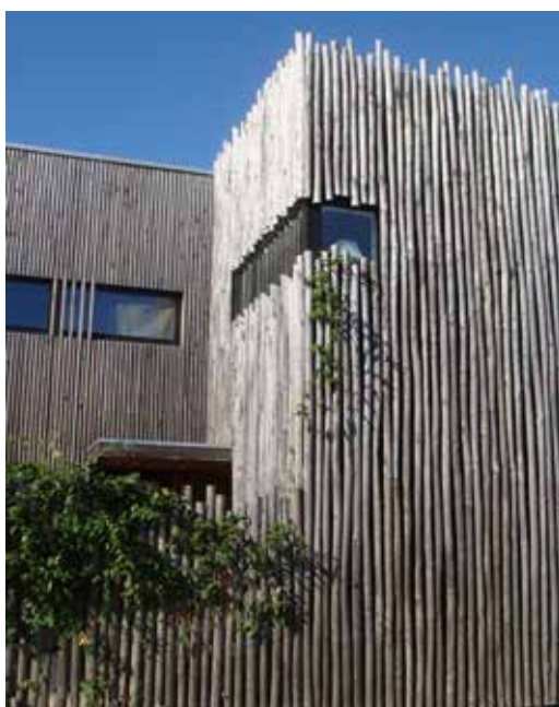
Maison T. Mixité des aspects extérieurs : association de résineux sciés posés à claire-voie et de châtaignier demi-rond
